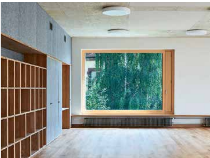
Wandfüllendes Möbel mit Schränken und Fächern sowie Zu- und Abluft. (Foto: Hochbauamt Basel-Stadt)
